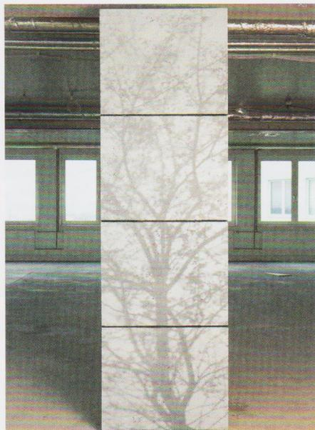
Fassaden und Wände mit Baumschatten auf Beton
